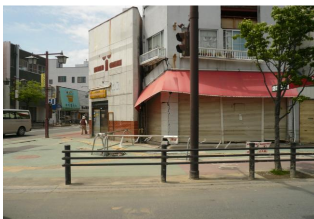
【地震による被害？】
